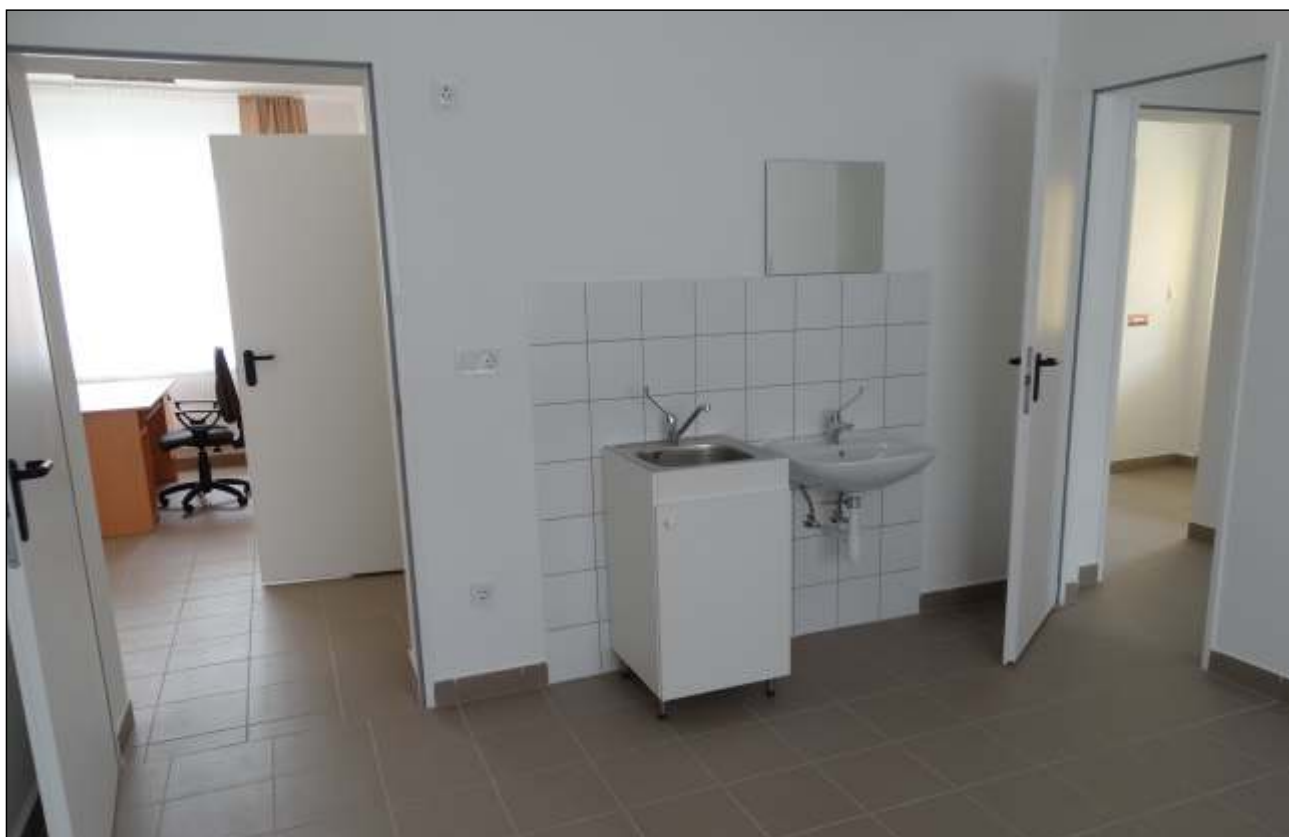
A Pócsperri Egészségügyi Központ felújítás fotól
